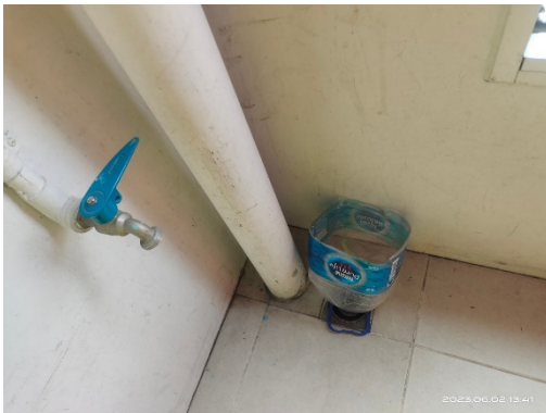
รูปที่ 22 ท่อรวบรวมน้ำเสียห้องพักขยะ
