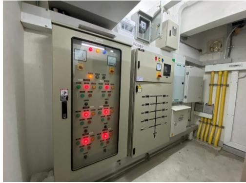
รูปที่ 5 มิเตอร์ไฟฟ้าระบบบำบัดน้ำเสีย
